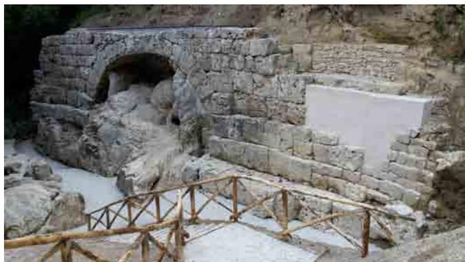
Il sistema di opere idrauliche d'età romana della Cascata delle Marmore è stato oggetto di una ricerca della relatrice a partire dallo scavo e analisi tecnica del c.d. "Ponte del Toro": trattasi di un'imponente infrastruttura idraulica, interpretabile come la mostra monumentale di un canale scolmatore deputato allo smaltimento delle acque in eccesso dalla piana di Reate verso il distretto contermine di *Interamna Nahars*.
